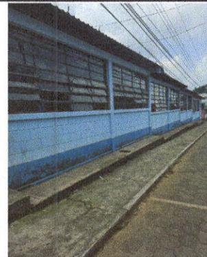
Foto 4: Sustituciones de balcones de metal
